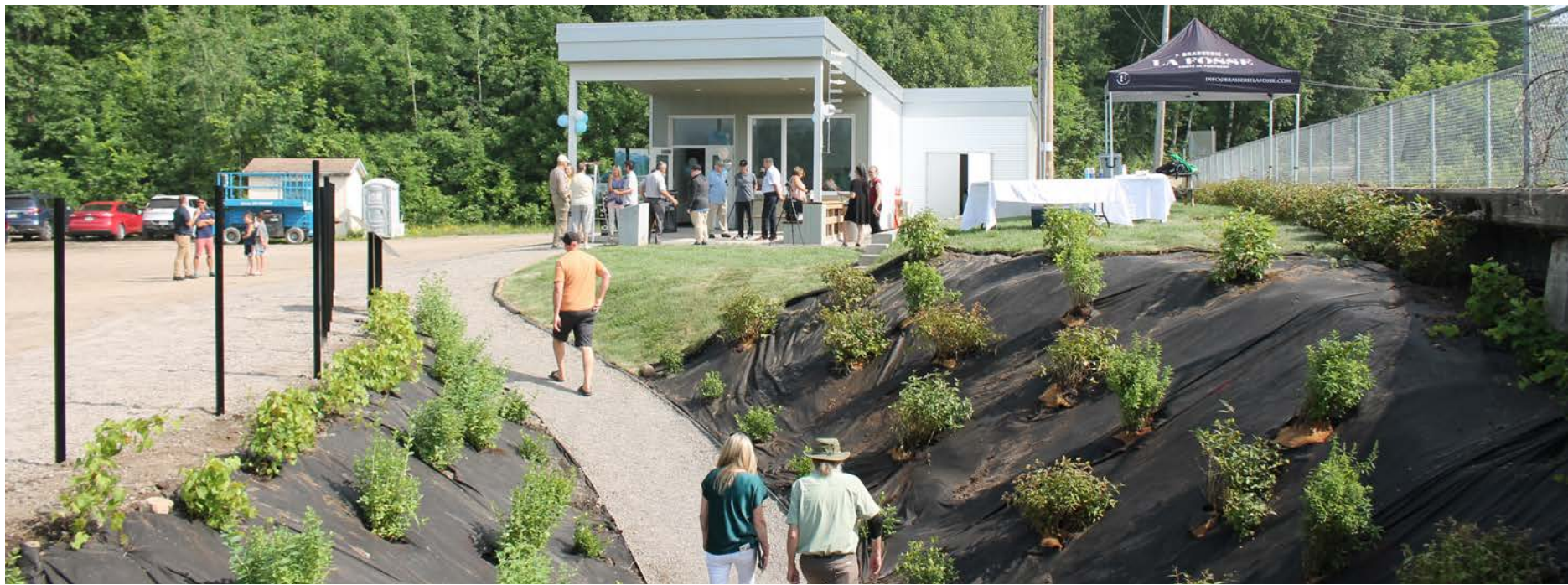
La descente conduisant aux fenêtres d'observation de la passe migratoire, avec à sa tête, le pavillon d'accueil. Photo - Stéphane Pelletier
