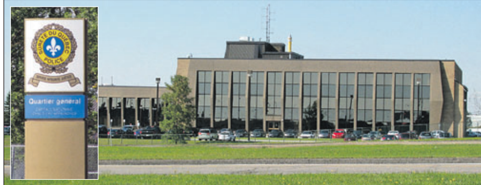
L'édifice de la SQ est située dans la zone industrielle Lebourgneuf.
