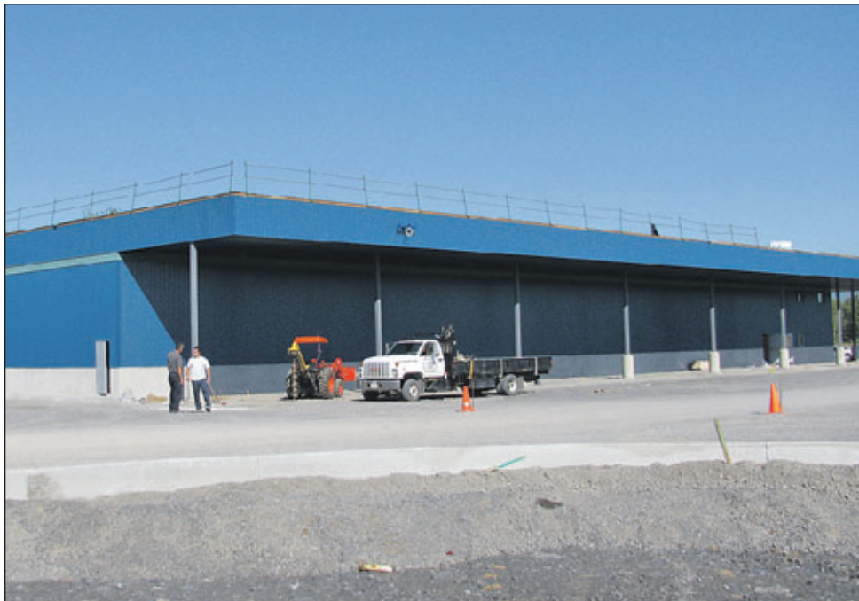
De nouvelles constructions s'élèvent.
