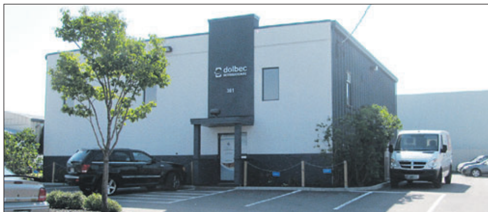
Dolbec Logistique Internationale a ses bureaux dans ce parc industriel.
