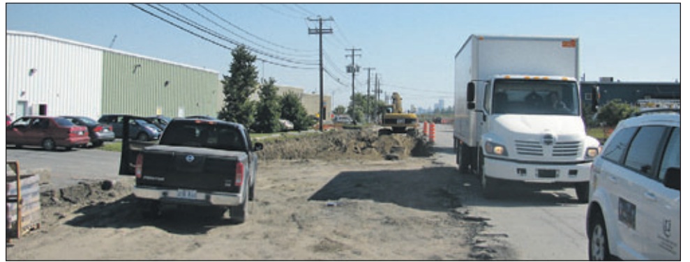
Les travaux rendent la circulation difficile.
