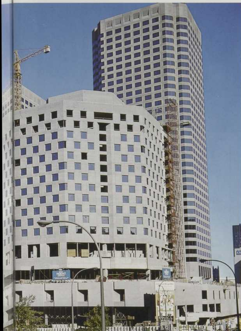
en béton coulé en œuvre et ses murs-rideaux en béton préfabriqué.
