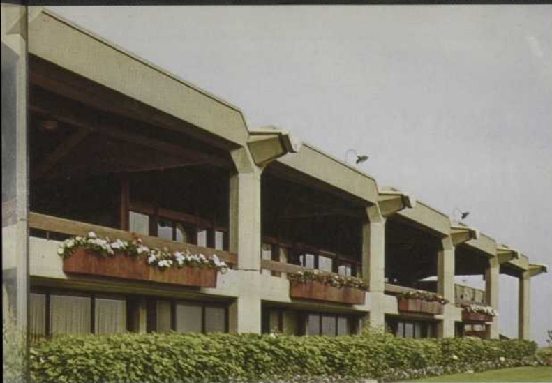
construit en béton coulé en œuvre, est à l'épreuve des incendies.
