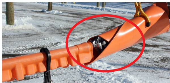
Mauvaise superposition des protecteurs
