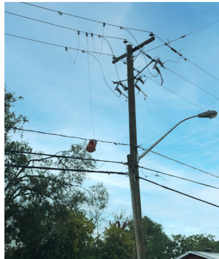
Mise à la terre d'une ligne moyenne tension pour en mettre une partie hors tension
