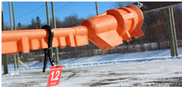
Protecteurs correctement installés
