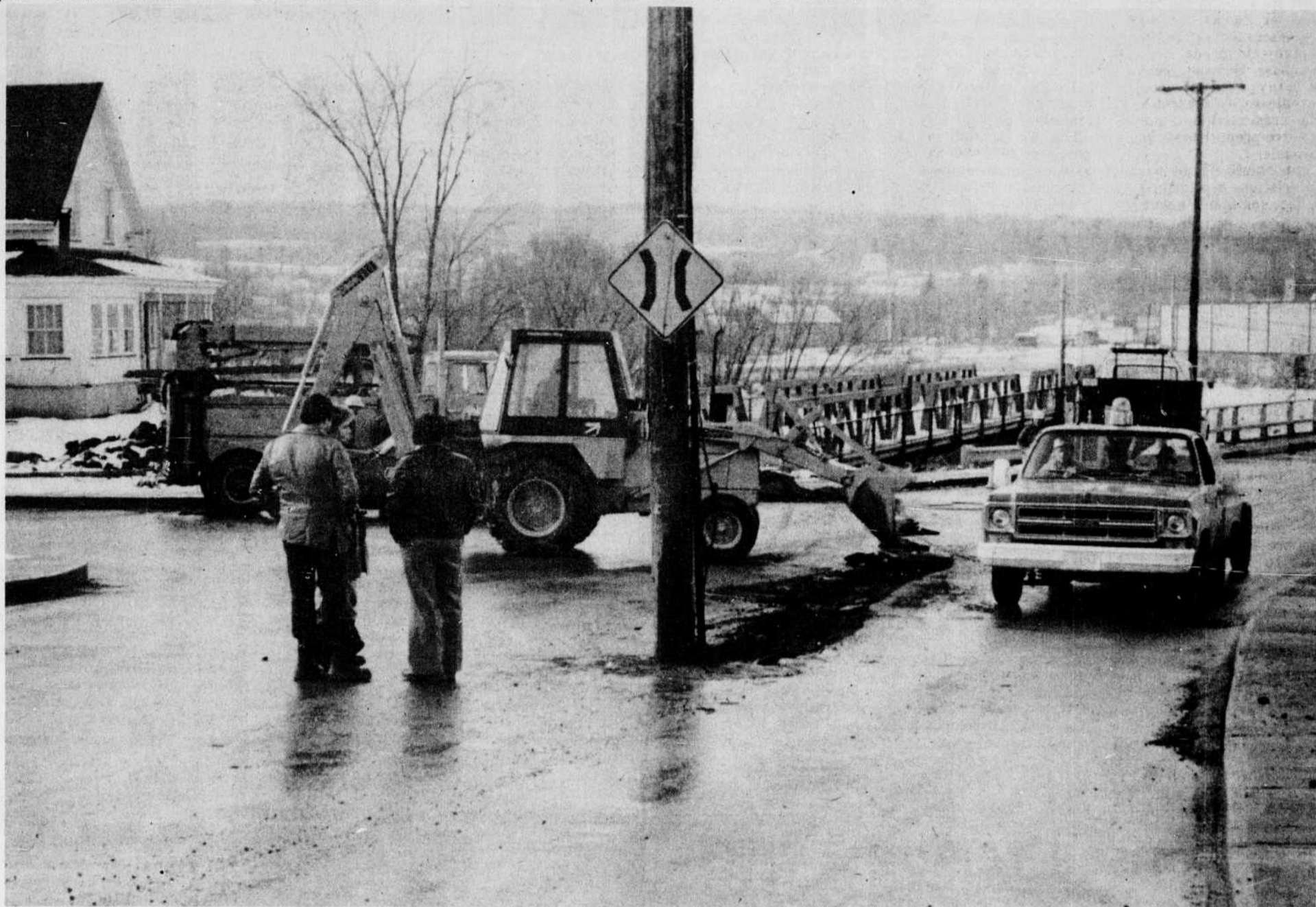
A la très grande satisfaction des usagers, les deux poteaux érigés aux extrémités du pont Vel seront enlevés sous peu. Déjà les employés de la compagnie Bell ont commencé les travaux préliminaires de relocalisation des conduits.
