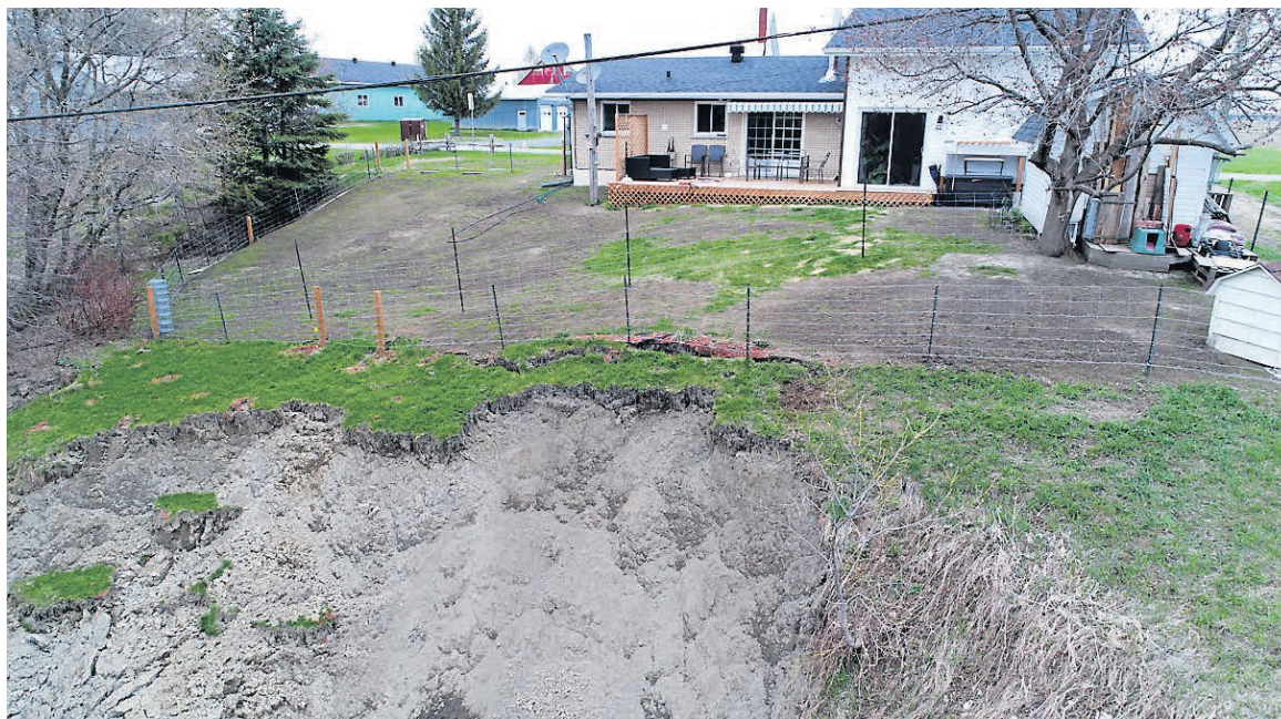
Cette photo prise en mai dernier démontre l'ampleur du glissement de terrain survenu derrière la maison.
