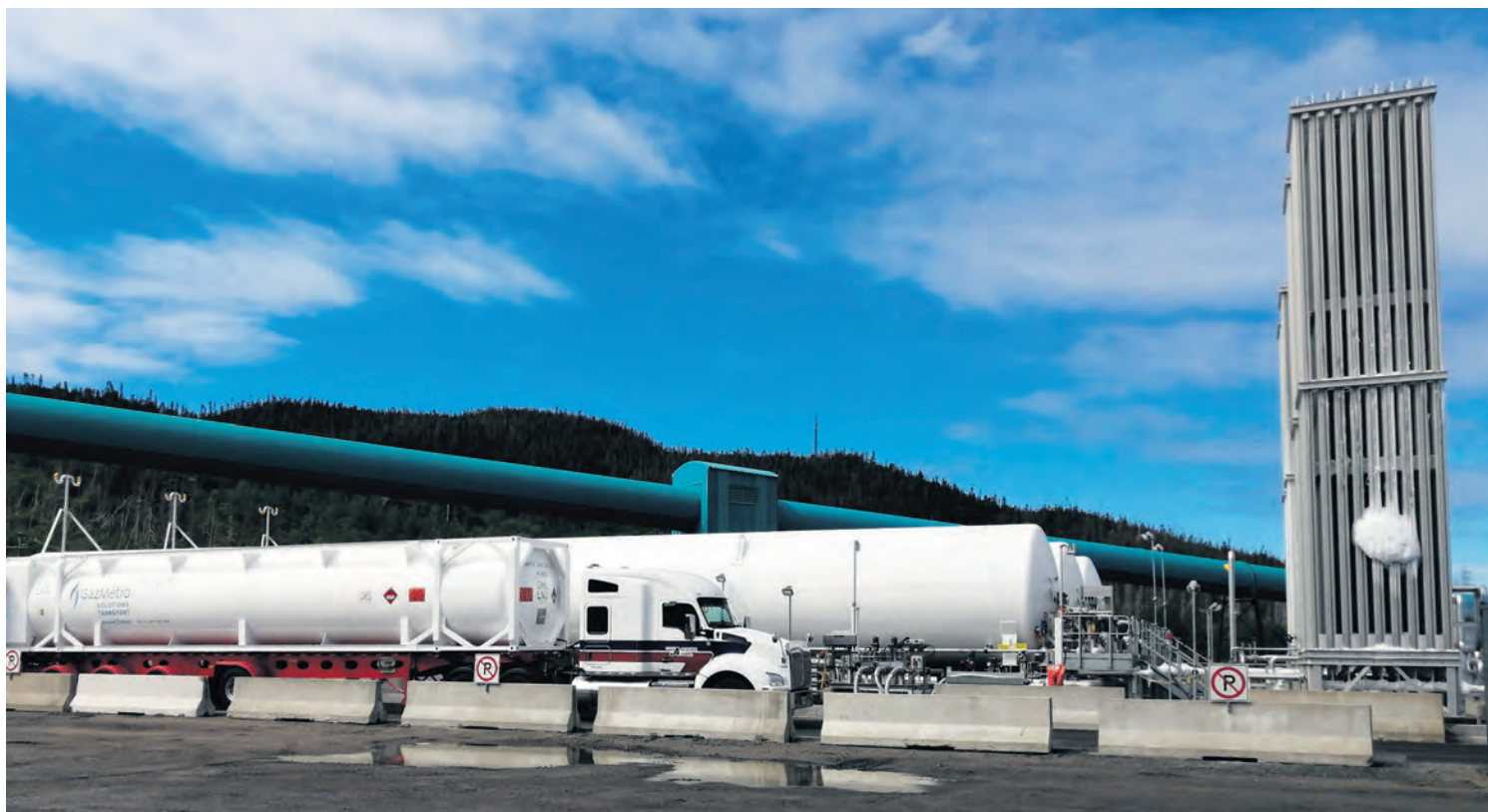
Le gaz naturel liquéfié est transporté par camion. Une fois arrivée au site d'Aluminerie Alouette, il est transféré dans les réservoirs. Il est à une température de -160 degrés Celsius. Le gaz passe ensuite dans les tours, où il se transforme d'un état liquide à gazeux.
