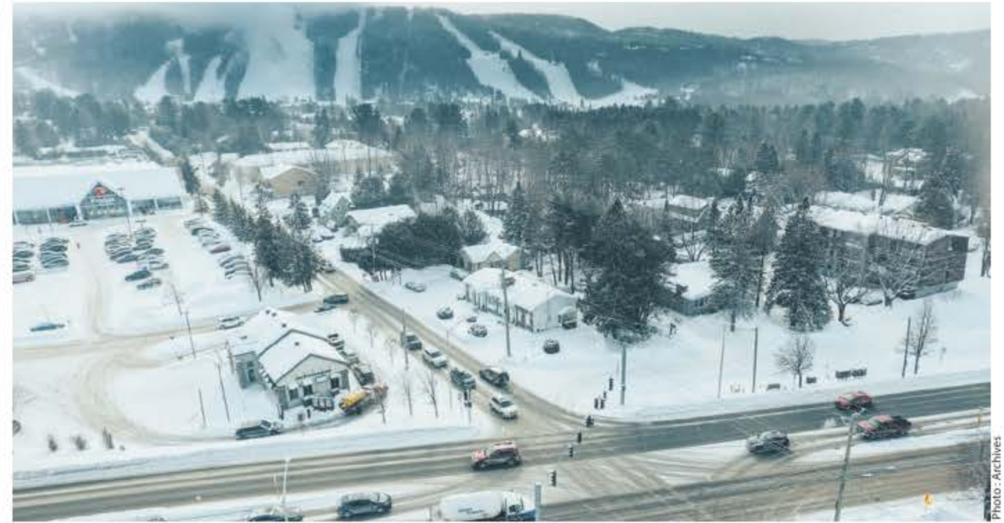
Pour l'année 2023, 11,7 M$ de dépenses, en parties subventionnées, sont prévues en tuyaux d'aqueduc.
