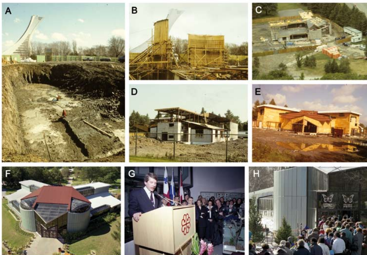
Figure 1 - Construction et inauguration de l'Insectarium de Montréal
