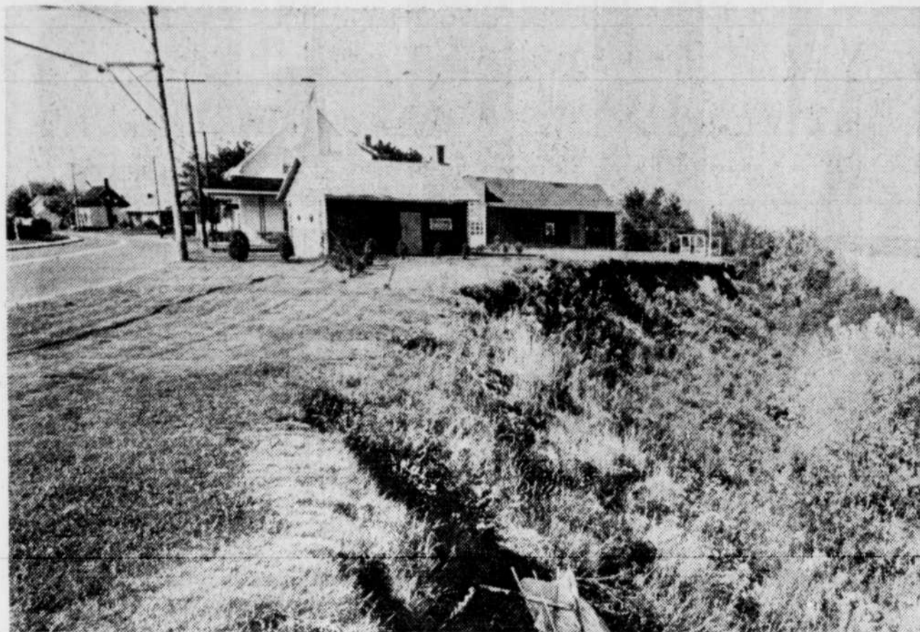
A l'entrée du village, on peut facilement remarquer que la falaise s'effrite et glisse graduellement vers le fleuve.
