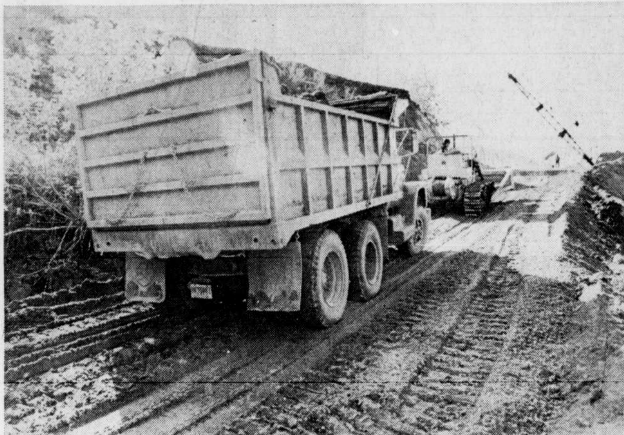
Un bélier mécanique doit guider les camions, car le sol est trop mou.
