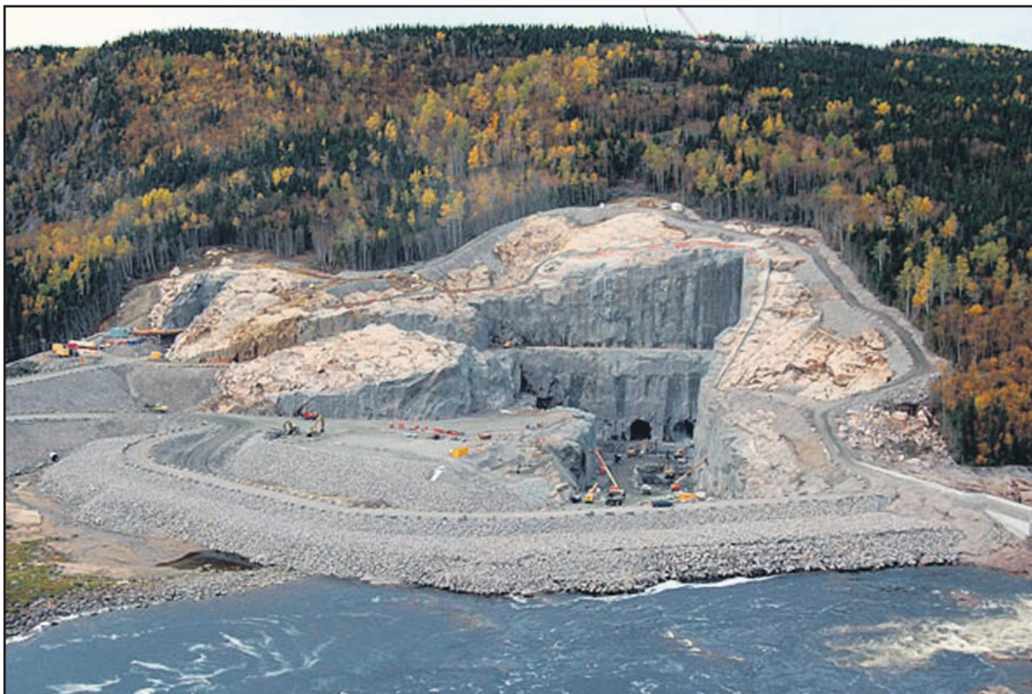
Le rapport de la CNESST évoque bon nombre de lacunes au niveau des règles de contrôle pour expliquer le décès de Luc Arpin des Escumins. Photo courtoisie
