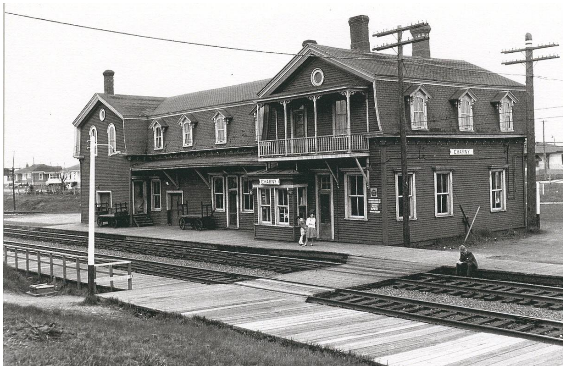
La gare de Charny peu avant la rénovation de 1961. (Photo tirée De : Petite histoire de Charny, t'embarques, Charny, 1978, p.28
