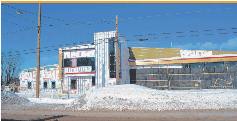
Les travaux de construction de la nouvelle caserne incendie progressent selon l'échéancier prévu. (Photo www.lanouvelle.net)
