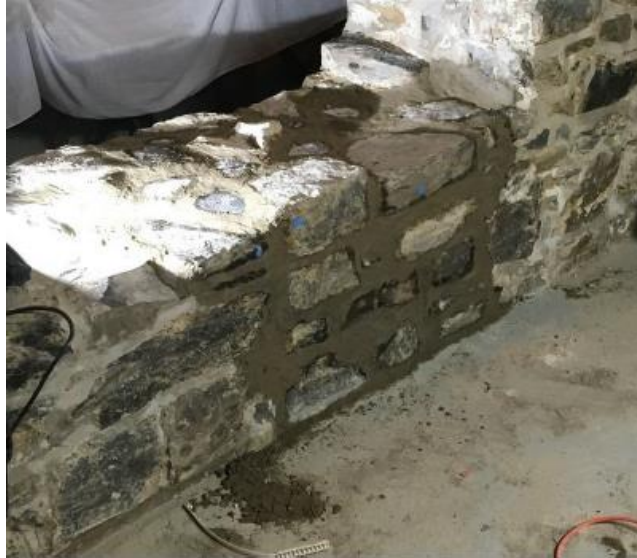
Photo 11 : muret après l'ouverture exploratoire
