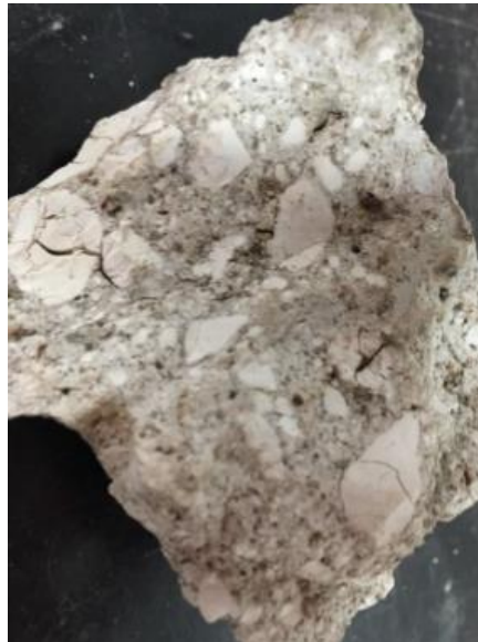
Photo 8 : mortier de pose prélevé (n os 3.7 et 3.7a) à l'intérieur du muret (sec)
