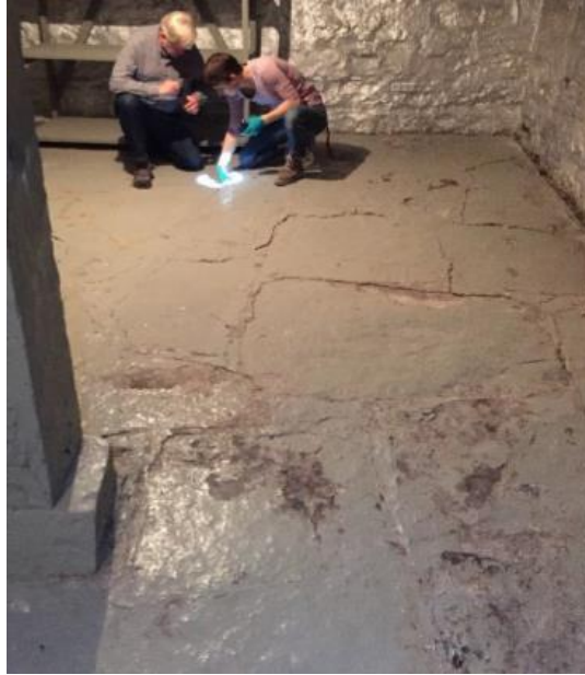
Photo 15 : dalle de calcaire, sous-sol du réfectoire
