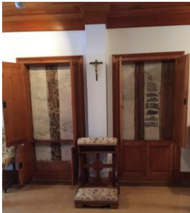
Photo 12 : accès au mur de colombage au rez-de-chaussée, par la sacristie
