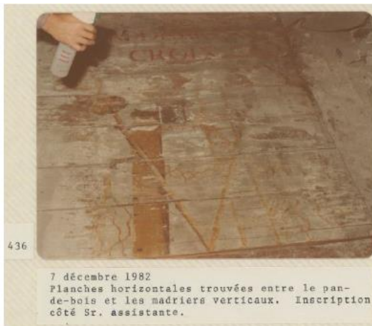
Photo 35 : Photo de 1982 montrant l'humidification de la surface de la murale pour saturer les couleurs et mieux voir les détails
