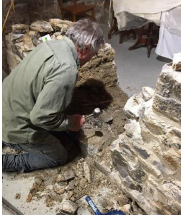
Photo 5 : ouverture exploratoire dans le muret sous la sacristie
