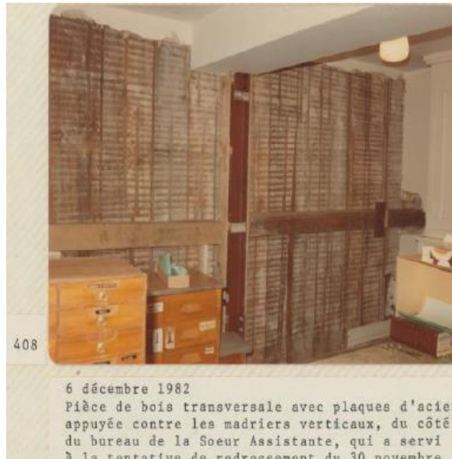
Photo 29 : démontage du mur enduit de plâtre, photo de 1982
