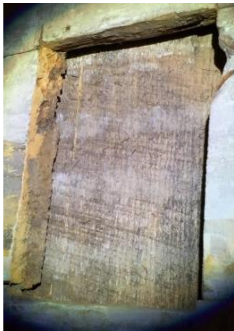
Photo 28 : marques de sciage irrégulières et légèrement inclinées sur les planches à l'arrière
