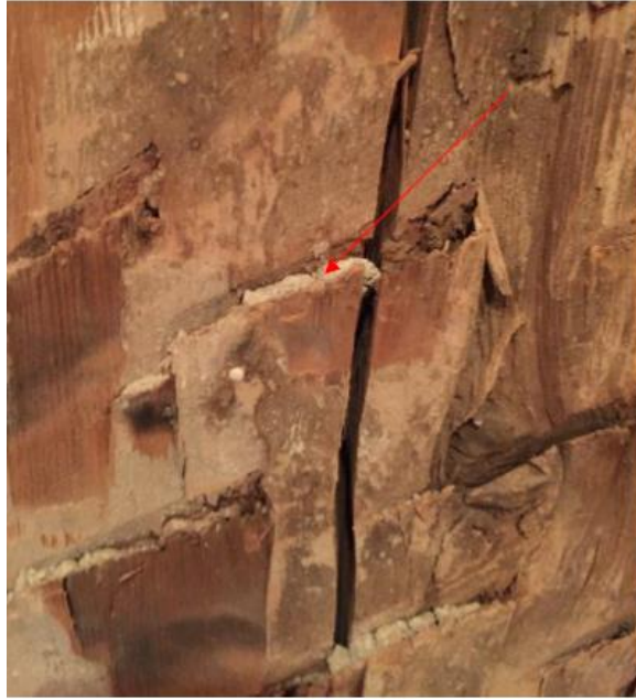
Photo 13 : mortier prélevé (n° 3.6) dans une entaille de la poutre du colombage
