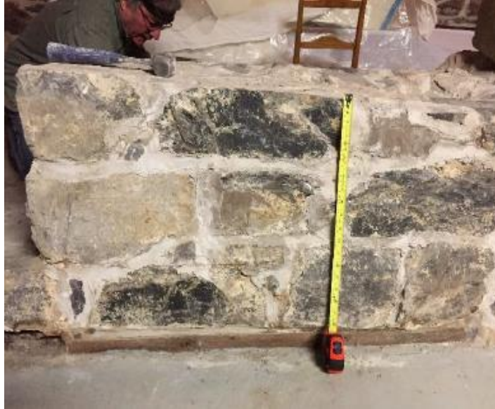
Photo 1 : calcaire de Beauport, muret sous la sacristie
