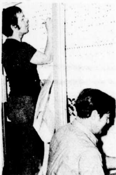
LA FACADE N'A DE SIGNIFICATION QU'A PARTIR DU CERVEAU et c'est ici, à l'arrière que se trouveront les appareils, terminaux, fusibles, résistances, conducteurs, sélecteurs à tourelles et quoi encore, qui feront vraiment le travail de manoeuvre. MM. Jean-Eudes Gauthier et Honoré Petitpas y font leur travail d'électriciens.
