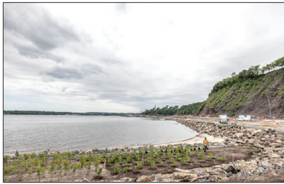
Les travaux d'aménagement des berges s'achèveront aussi au cours de l'été et permettront plusieurs accès au fleuve.
