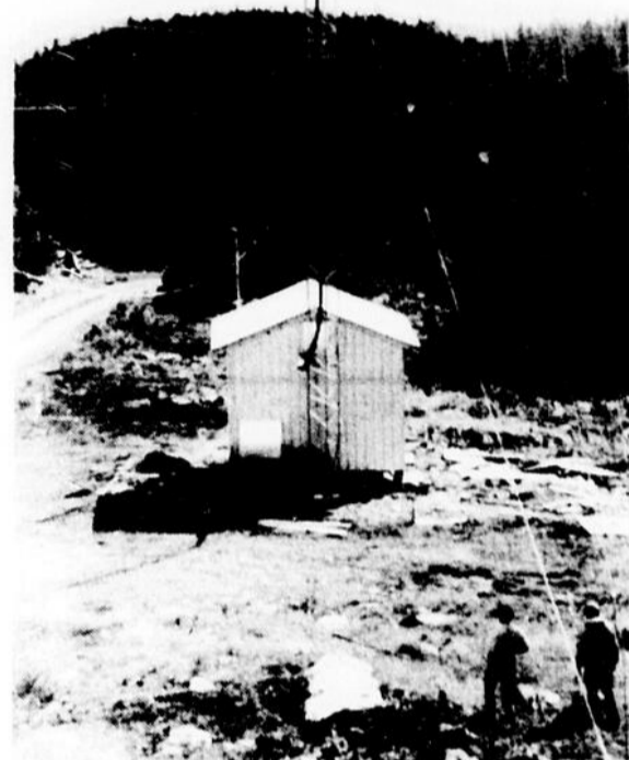
Des installations impressionnantes. La photo montrant le bas de la tour d'une hauteur de 150 pieds de CION-FM, vous donne une juste perspective de l'importance des installations de diffusion de Radio Grand-Portage. Vous pouvez aussi voir la ligne de transmission au centre de la tour.
