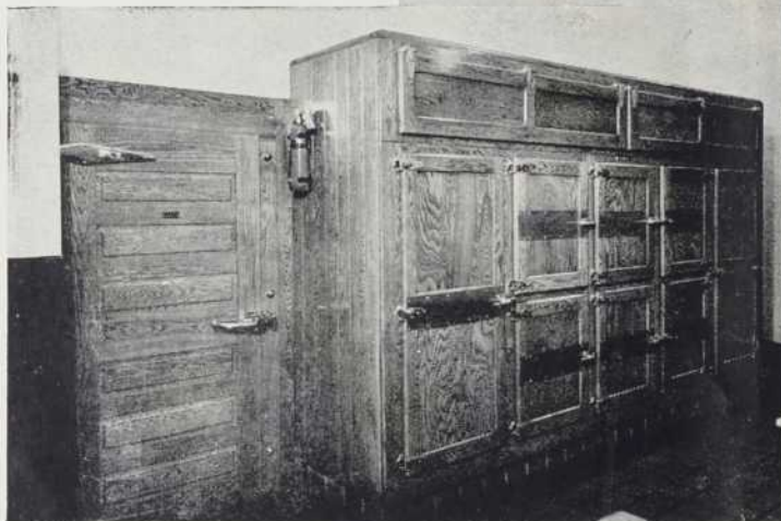
Les réfrigérateurs accessibles de l'extérieur et les chambres frigorifiques pour les cuisines du nouveau restaurant Murray's à Montréal
