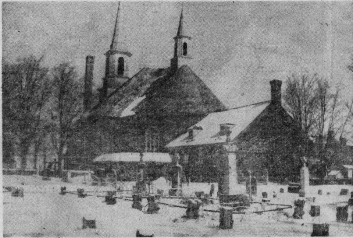
L'église paroissiale construite en 1871
