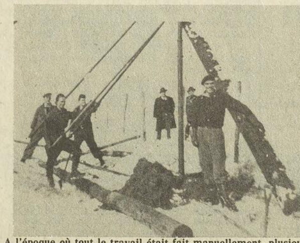
A l'époque où tout le travail était fait manuellement, plusieurs monteurs de lignes devaient se donner la main pour fixer un poteau.
