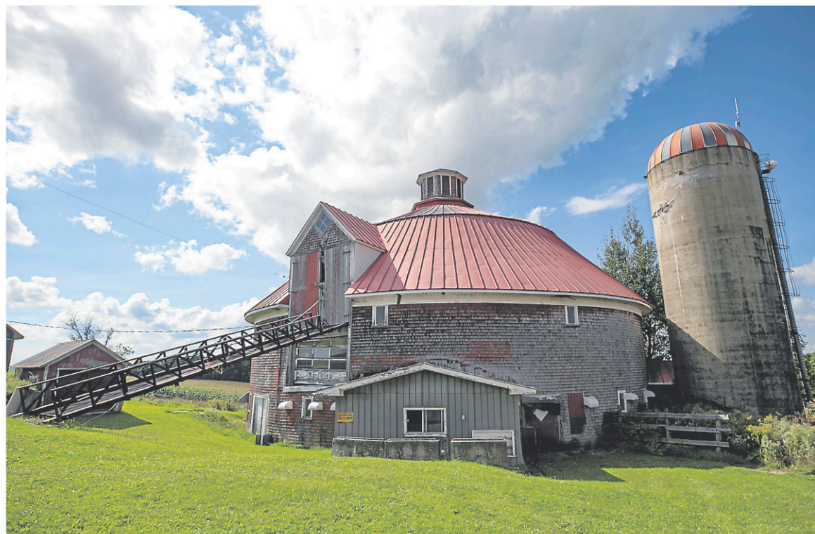
Trésors d'architecture uniques des Cantons-de-l'Est, les granges rondes sont presque aussi difficiles à dénicher en 2018 qu'une aiguille dans une botte de foin pour les touristes. Ci-dessus, la grange à Barnston. — PHOTO LA PRESSE, DAVID BOILY
