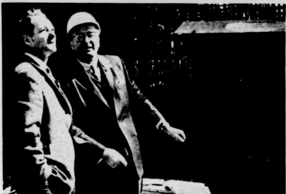
LE DEPUTE DE ST-AURICE à l'Assemblée législative, Me Jean-Guy Trepanier, a visité le chantier de construction du viaduc dans les limites de la ville de Shawinigan-Sud. Il s'est dit vivement intéressé et heureux de la marche des travaux. M. Marcel Gauthier, qui a ob-
