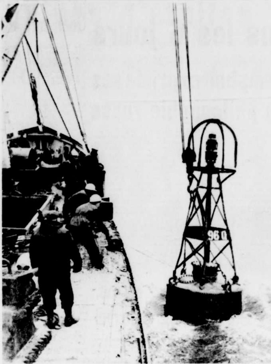
LE SAFEGUARDER préposé à l'entretien des bouées pour l'Agence de Sorel, procède à la pose des bouées dans le chenal du fleuve St-Laurent. On voit, sur la
