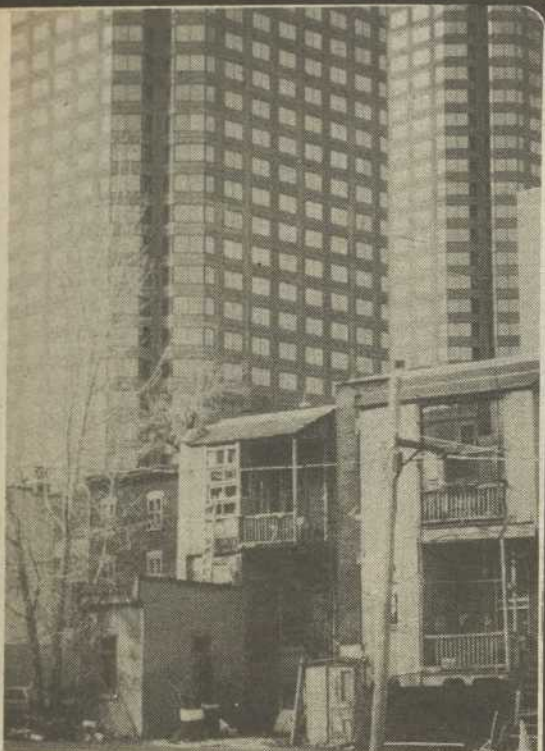
Contraste des immeubles construits à différentes époques dans le centre de Montréal, près du Complexe Desjardins.
