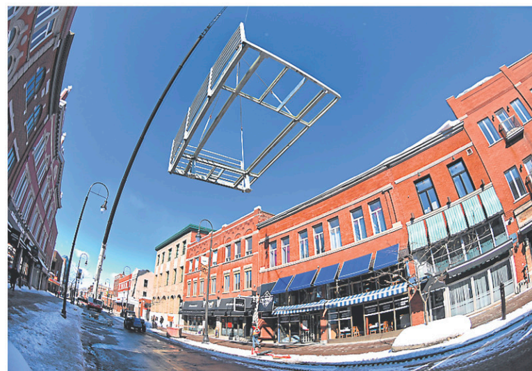
La grue est en place sur la rue des Forges. — PHOTO: FRANÇOIS GERVAIS
