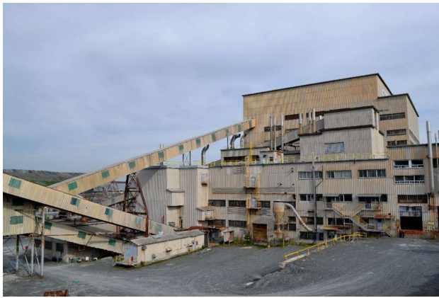
Mine Lac d'amiante. Vue générale du moulin et des convoyeurs.
