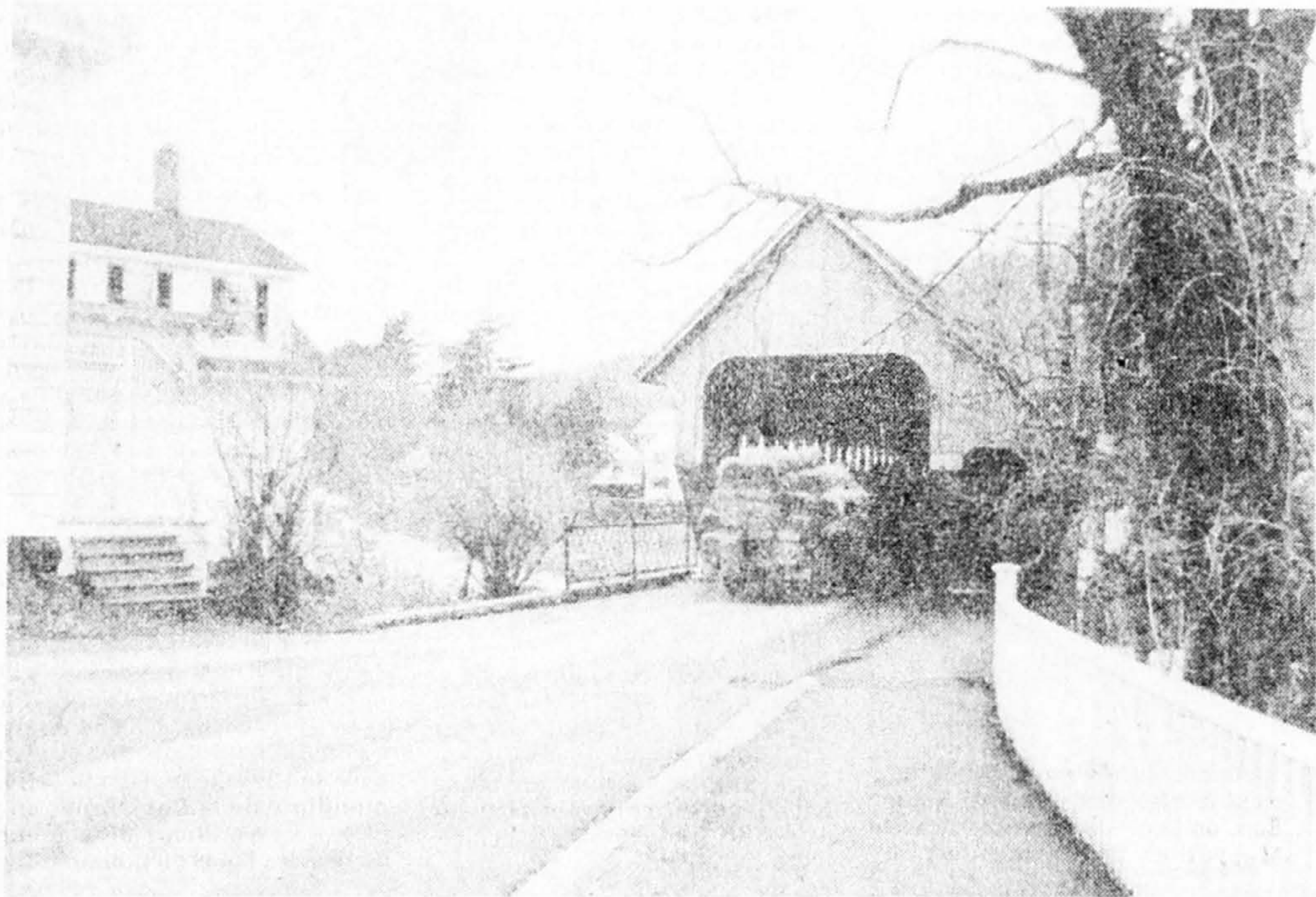
Le pont couvert au centre du village
