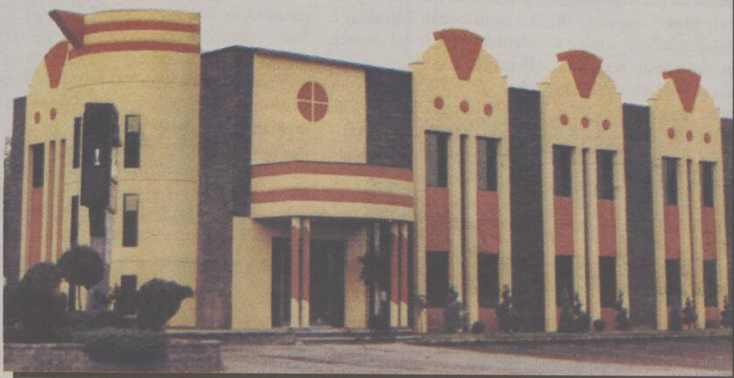
L'esterno del complesso "Le Marco" interamente rinnovato
