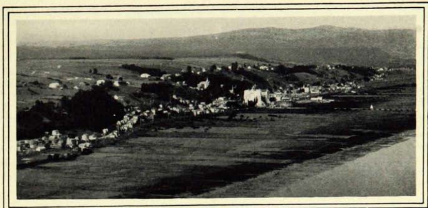
Ste-Anne-de-Beaupré, showing shrine under construction (Compagnie Aérienne Franco Canadienne, Montreal)
