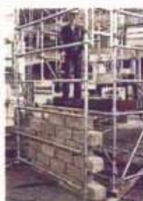
Échafaudage de pied
