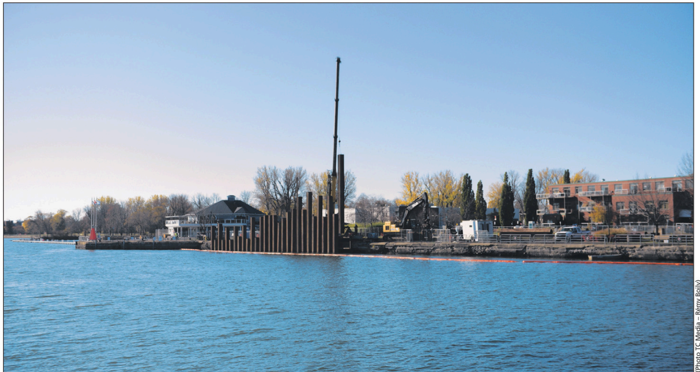
Actuellement, l'entrepreneur construit une estacade à l'aide de palplanches. Cet ouvrage temporaire permettra d'assécher la zone de travaux.
