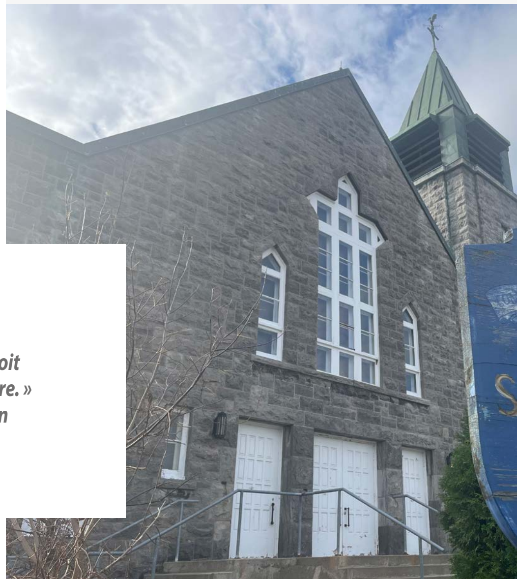
L'église Très-Saint-Coeur-de-Marie a été construite en 1949. (Photo : Jean-Christophe Noël)
