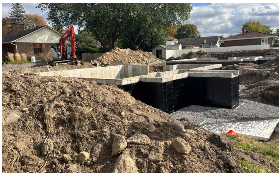
Deux triplex sont en construction à l'angle des 4 e Rue et 9 e Avenue à Richelieu.
