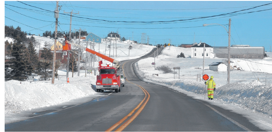
Plusieurs travailleurs et monteurs de lignes sont au travail dans tous les secteurs de la Ville de Percé. (Photo TC Media – Alain Lavoie)
