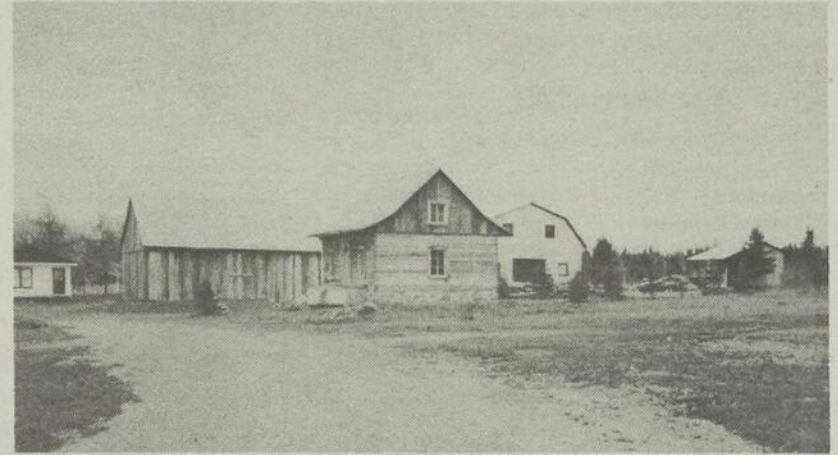
Les travaux vont bon train du Musée des Défricheurs.
