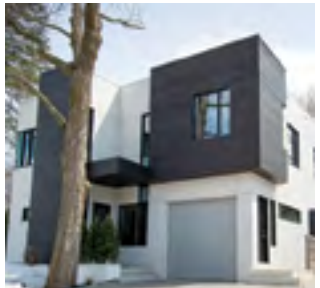
5 CAC + 2, 3 SDB. Construction exceptionnelle et Éco friendly.
