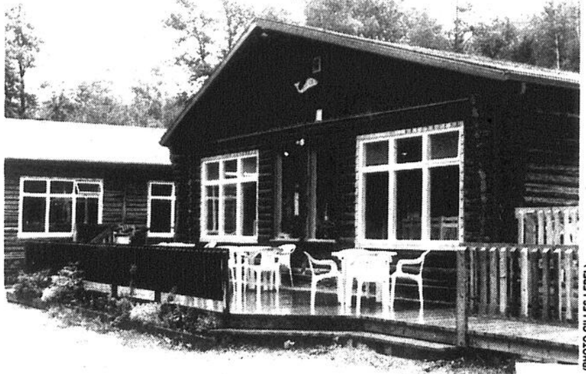
Les travaux touchent plusieurs bâtiments, principalement au niveau de la réfection de la toiture et d'une nouvelle fenestration.
