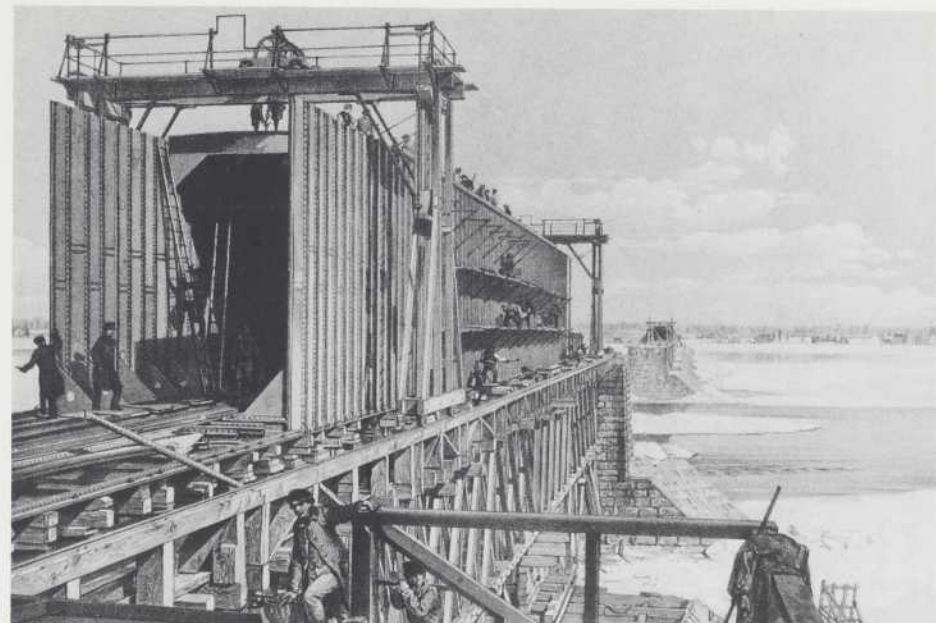
James Hodges (Grande-Bretagne: Queensborough, 1814-Bagshot, 1879). Construction of the Great Victoria Bridge in Canada (London: John Wenle, 1860). 59 x 42 cm. Planche en regard de la page 57: Vue du caisson central du pont Victoria en construction . Collection Centre Canadien d'Architecture, Montréal.
