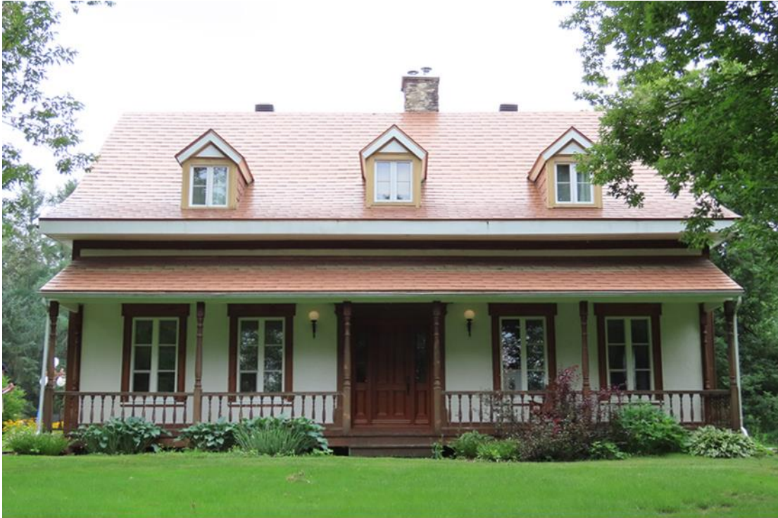
Manoir William-Milburn-Pozer Répertoire du patrimoine culturel du Québec La reconstruction sur les mêmes fondations après un incendie remonte à 1879
