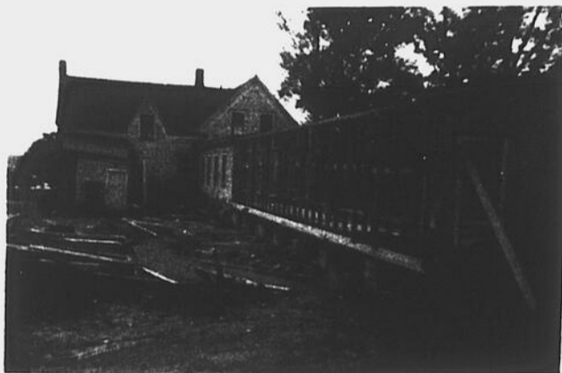
CONSTRUCTION SALLE DES CHEVALIERS - Cette photo des années 30 nous fait voir la construction de la salle des Chevaliers de Colomb, rue boulevard des Vétérans.
