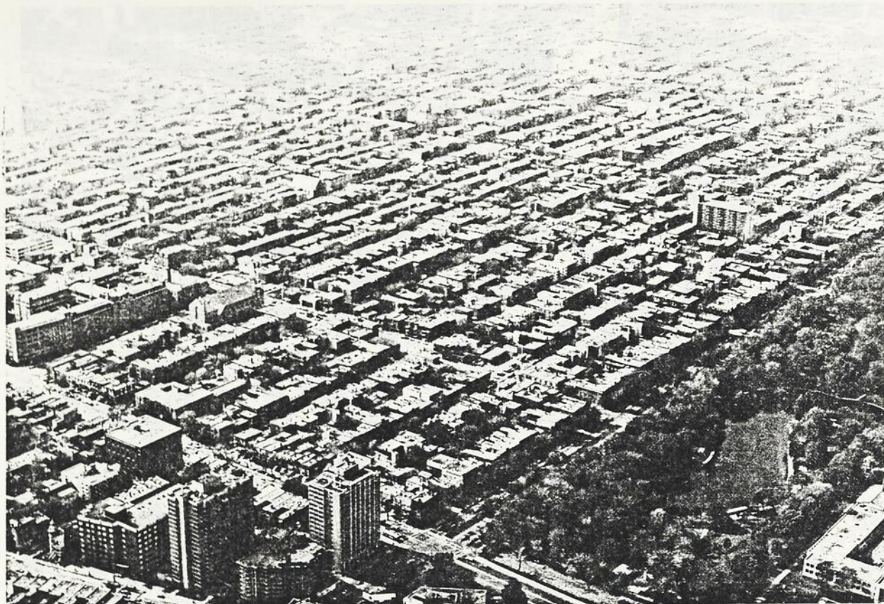
Fig. 2 Vue aérienne, intersection des rues Sherbrooke et Parc Lafontaine, vers le nord-ouest.
