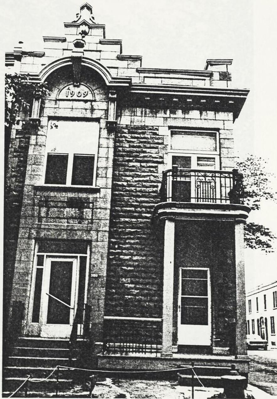
Fig. 30 Maison 3780 Parc La Fontaine.
