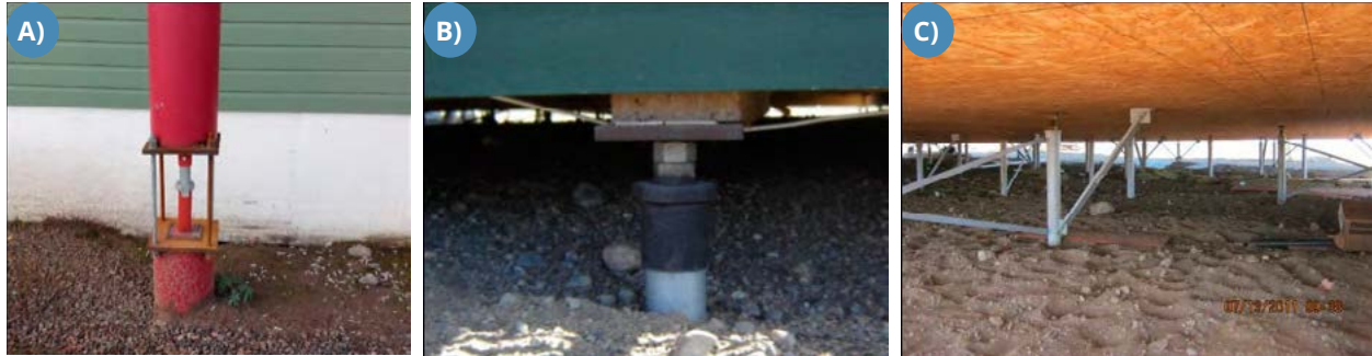
FIGURE 5.76 : A) ET B) TÊTES DE PIEUX AJUSTABLES (MENTION DE SOURCE : E. L'HÉRAULT, CEN, 2015). C) CONTREVENTEMENTS (SOURCE : N. JOURNEUX).
