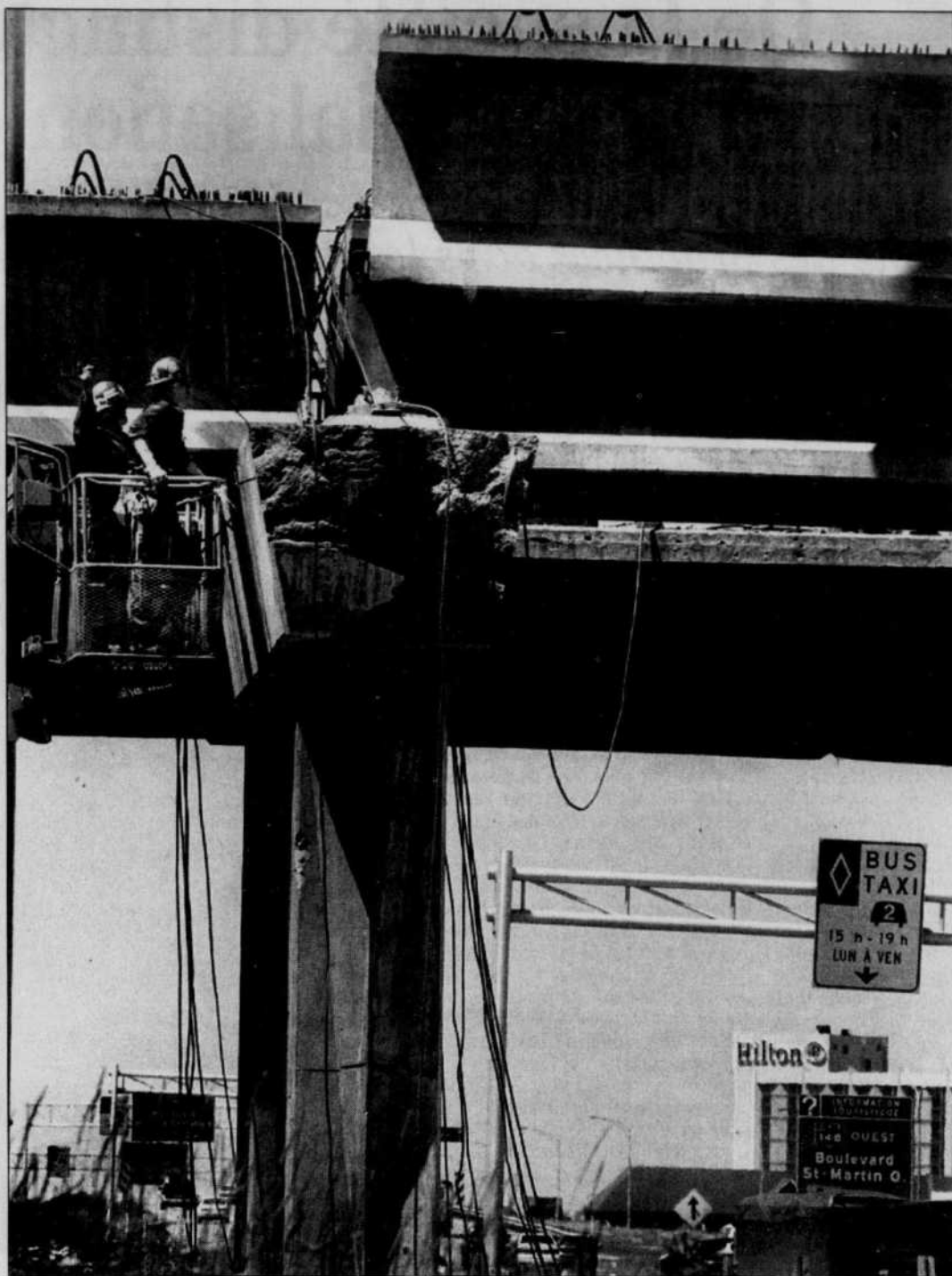
Les ouvriers ont commencé à retirer toutes les poutres du viaduc en début d'après-midi hier.
