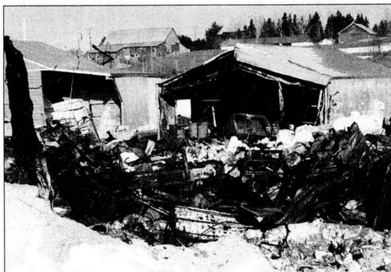
Les dommages sont importants.
