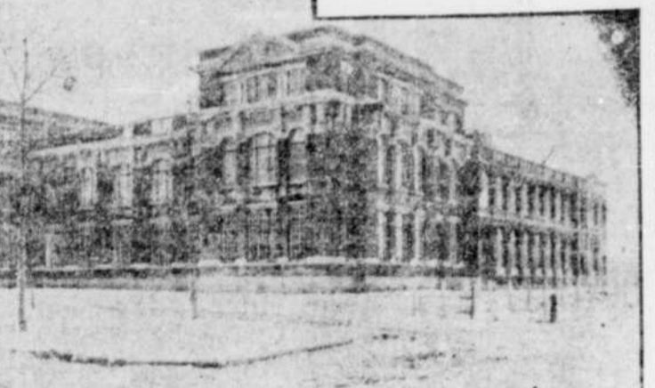
VUE DE FACE DE L'ÉCOLE TECHNIQUE DE QUÉBEC.
