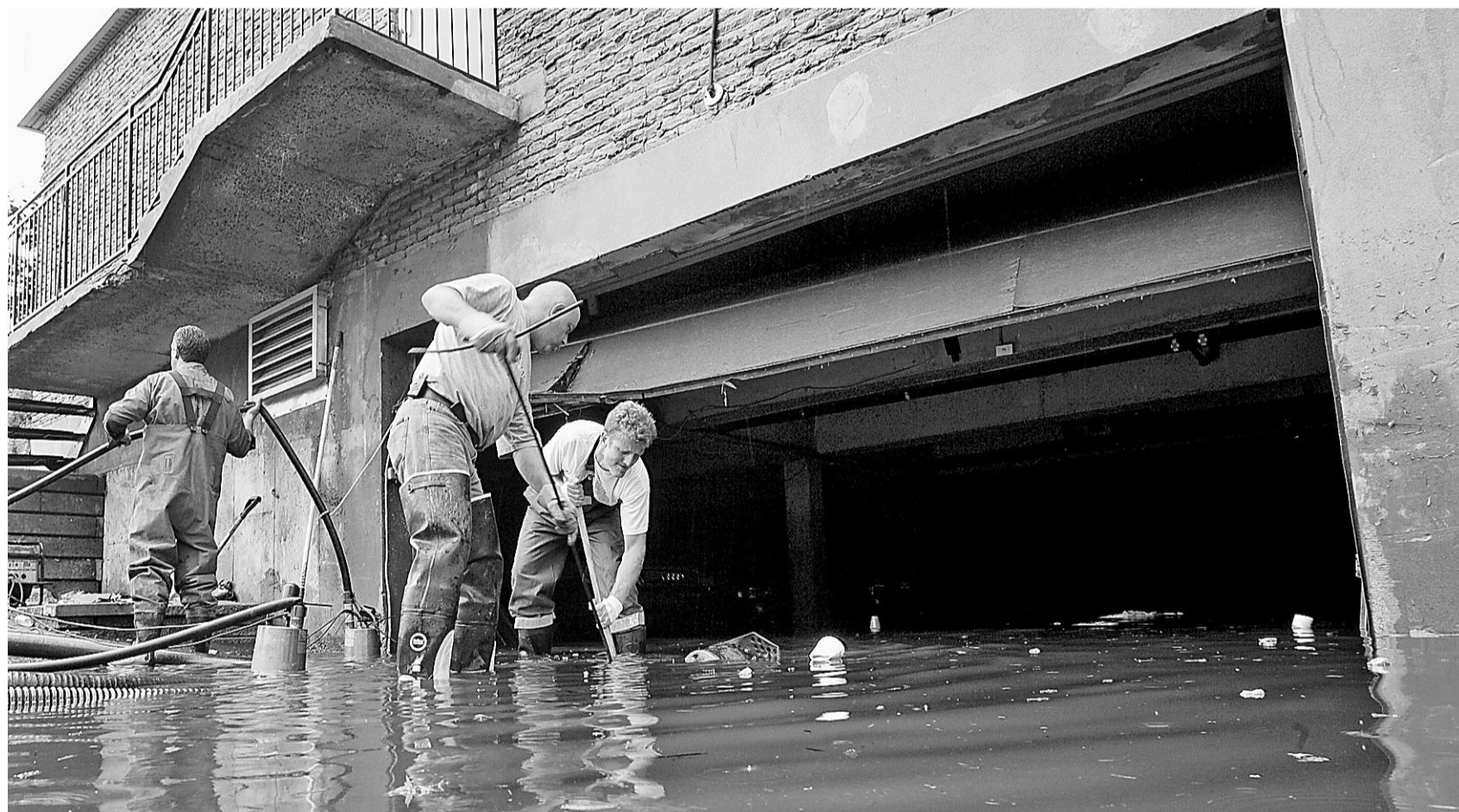
PHOTO ROBERT SKINNER, LA PRESSE Le garage d'un immeuble de la rue Champs-d'eau, à Anjou, a été complètement submergé en quelques heures samedi. Les employés de la Ville ont passé la matinée d'hier à pomper l'eau qui s'y était infiltrée.
