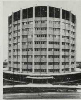
Edifice des Sciences médicales McIntyre, Université McGill
