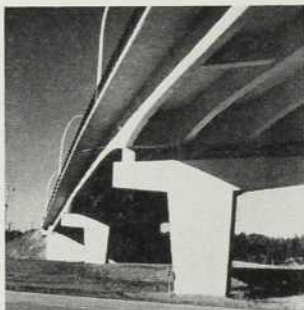
Ponts de l'autoroute Montréal-Laurentides
