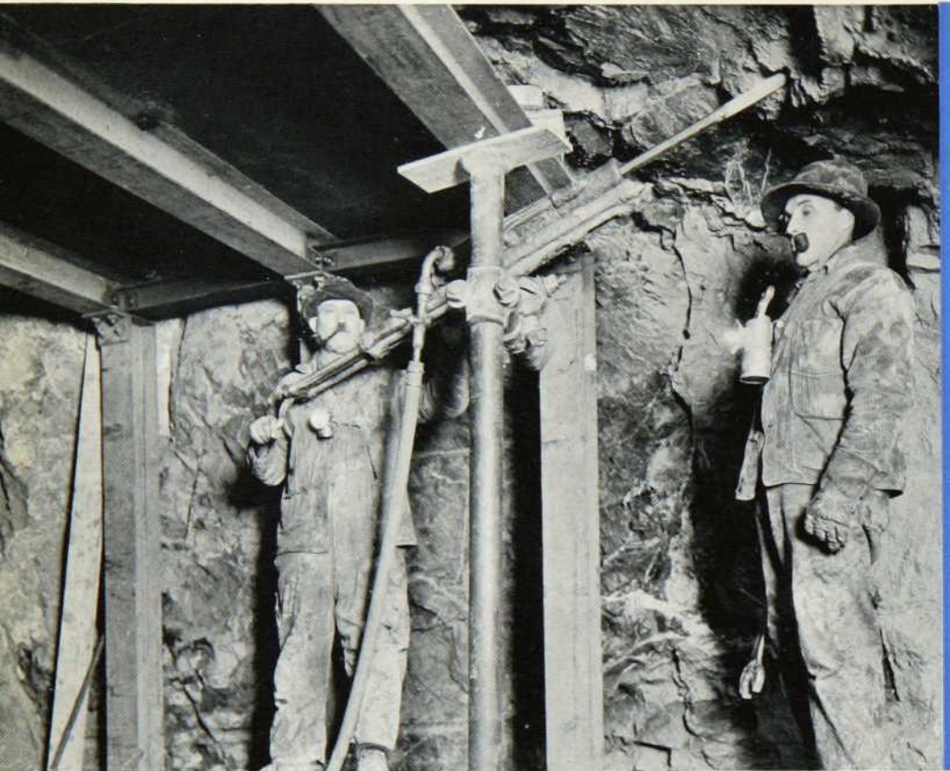
Deux mineurs se servant d'une foreuse pneumatique Gardner-Denver dans une mine d'amiante.
