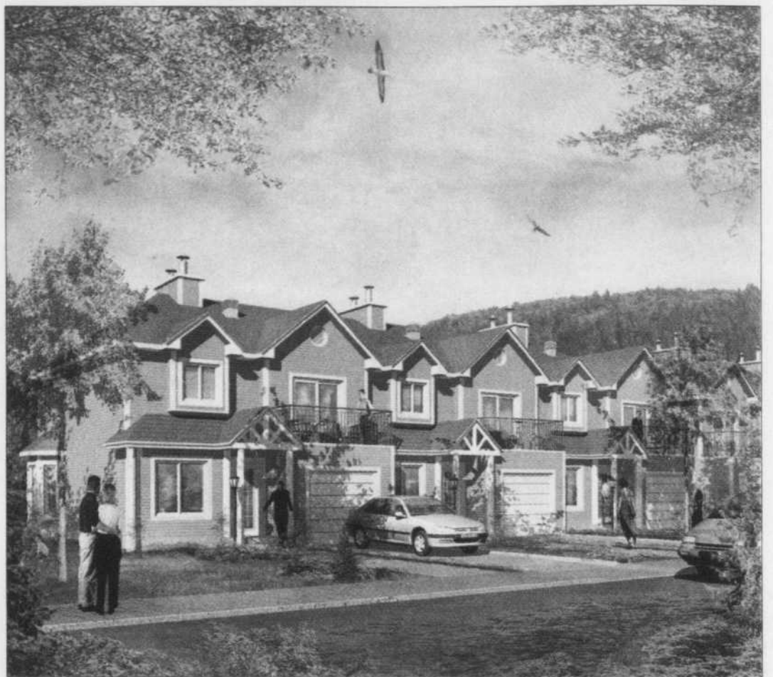
SOURCE LES CONSTRUCTIONS MIRASOL
