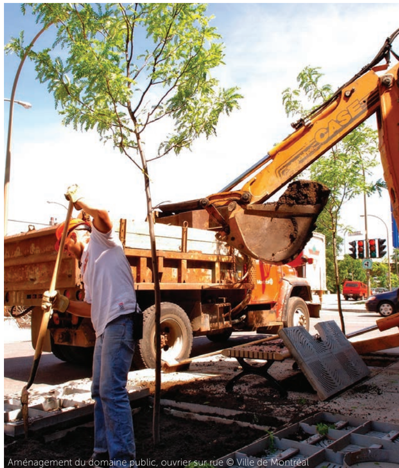
Aménagement du domaine public, ouvrier sur rue © Ville de Montréal
