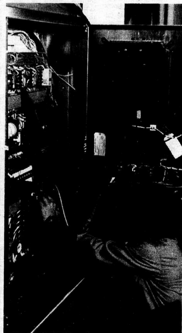
Un spécialiste installe des panneaux de contrôle de la nouvelle machinerie qui produira du beurre léger.
