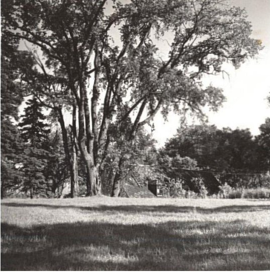
Figure 21- Vue du haut du coteau, on n'aperçoit que la toiture (intacte)
